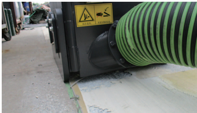
施工状況(切削廃材同時吸引)
