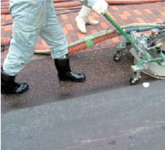
舗装作業の様子
