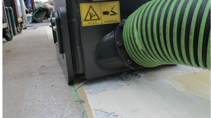
施工状況(切削廃材同時吸引)
