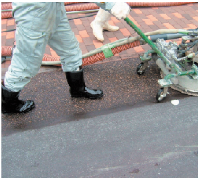
舗装作業の様子
