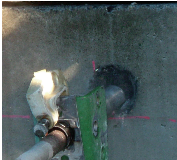
施工風景拡大
