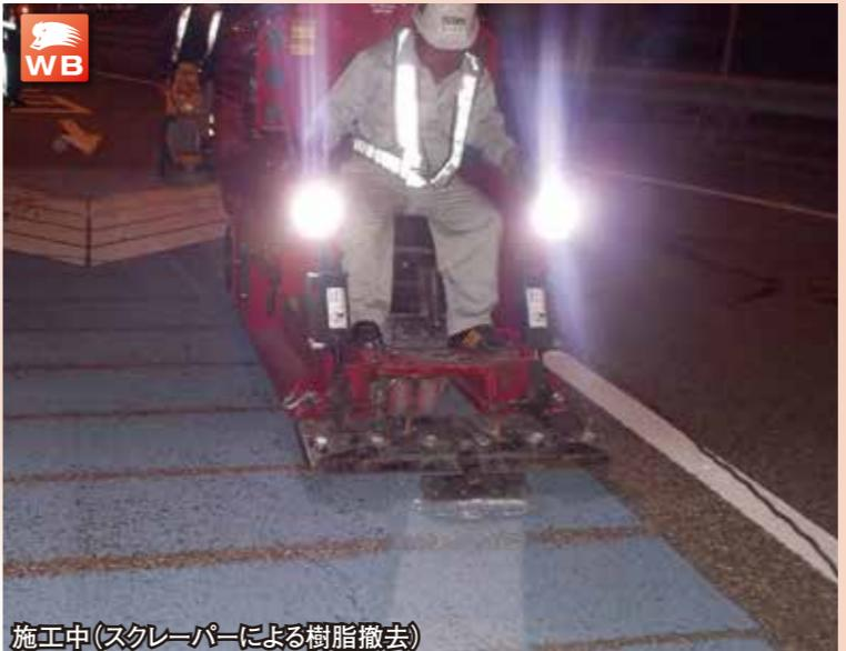
施工中(スクレーパーによる樹脂撤去)
