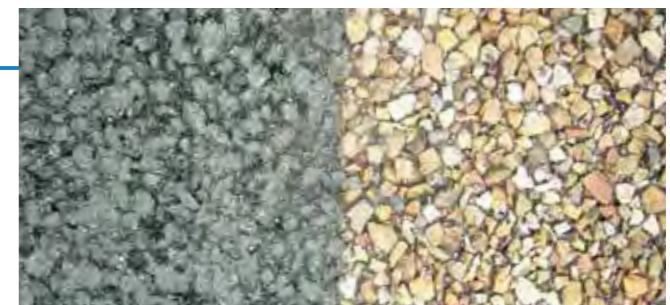
左:施工前 右:アクアサーフェス工法でアスファルト舗装表面の自然風仕上げ
