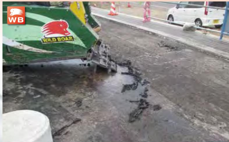
施工中(スクラーバーによる薄層除去)
