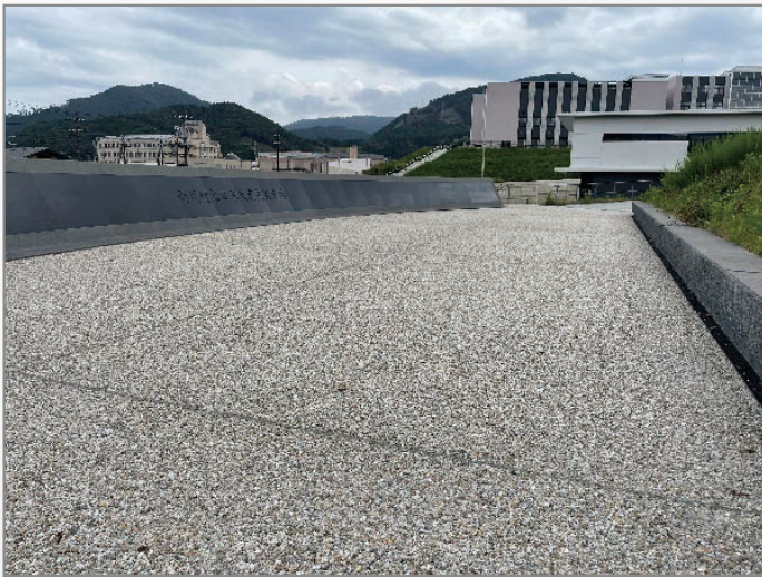
宮城県 東日本大震災慰霊碑前広場 (透水性Con舗装: SB)
