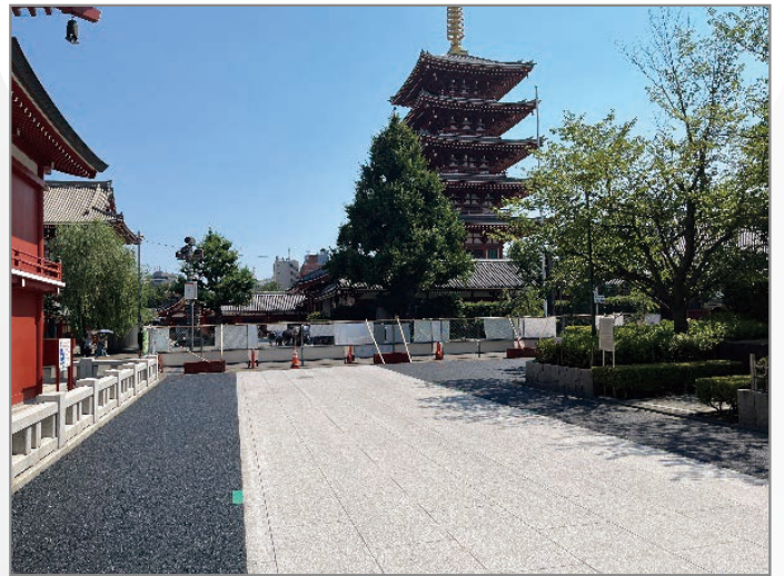
東京都 浅草寺境内 (半たわみ性舗装: SB)
