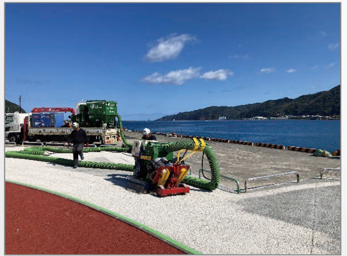
鹿児島県 奄美市名瀬港 (透水性Con舗装: SB)
